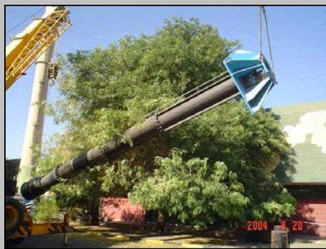
عملية رفع مضخة جديدة لتبريد المياه في مشروع الطاقة الكهربائية في بغداد والذي يتم تجديده وترميمه بدعم من الوكالة الأمريكية للتنمية الدولية USAID.
