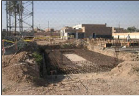
الاساس لمبنى الشب والتعقيم بالكلور في مشروع معالجة المياه.
