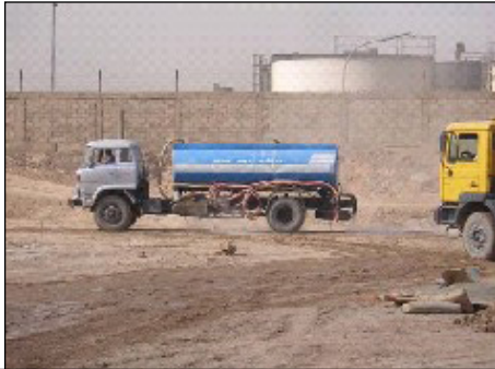
مركبة تقوم بتطبيق التربة في موقع لمشروع الطاقة الكهربائية ، حيث تم تحديد الغبار والأتربة كخطر يهدد صحة العمال خلال التقييم البيئي في هذا الموقع.
