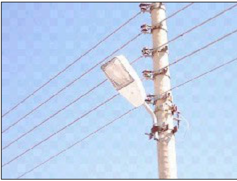
تم تتصيب نظام كهربائي جديد من قبل اعضاء المجتمع في محافظة نينوى.
