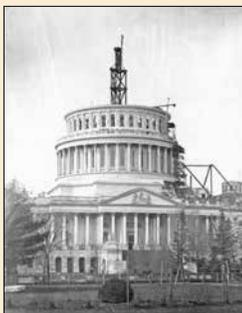
1861年，铸铁构造的穹顶工程已在全面进展中。
