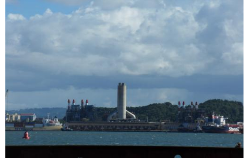
Foto 1: Termoeléctrica de Puerto Nuevo, San Juan Foto: SCT, Inc.
